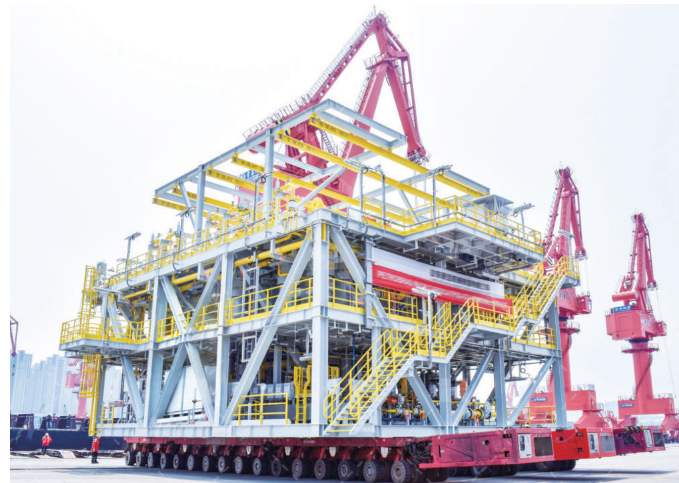
用于CARIOCA MV-30 FPSO 上的CO 2 处理模块 CO 2 Treatment Module for CARIOCA MV-30 FPSO
